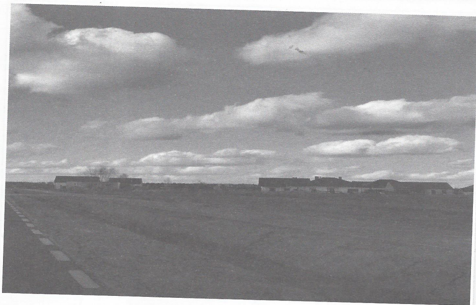
W trakcie realizacji : Ścieżka rowerowa przy drodze powiatowej Strykowo-Sapowice
